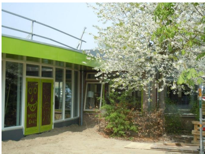
Verbouw van De Ark
